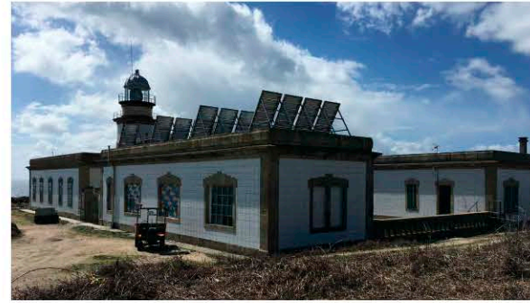
Estado actual del faro
